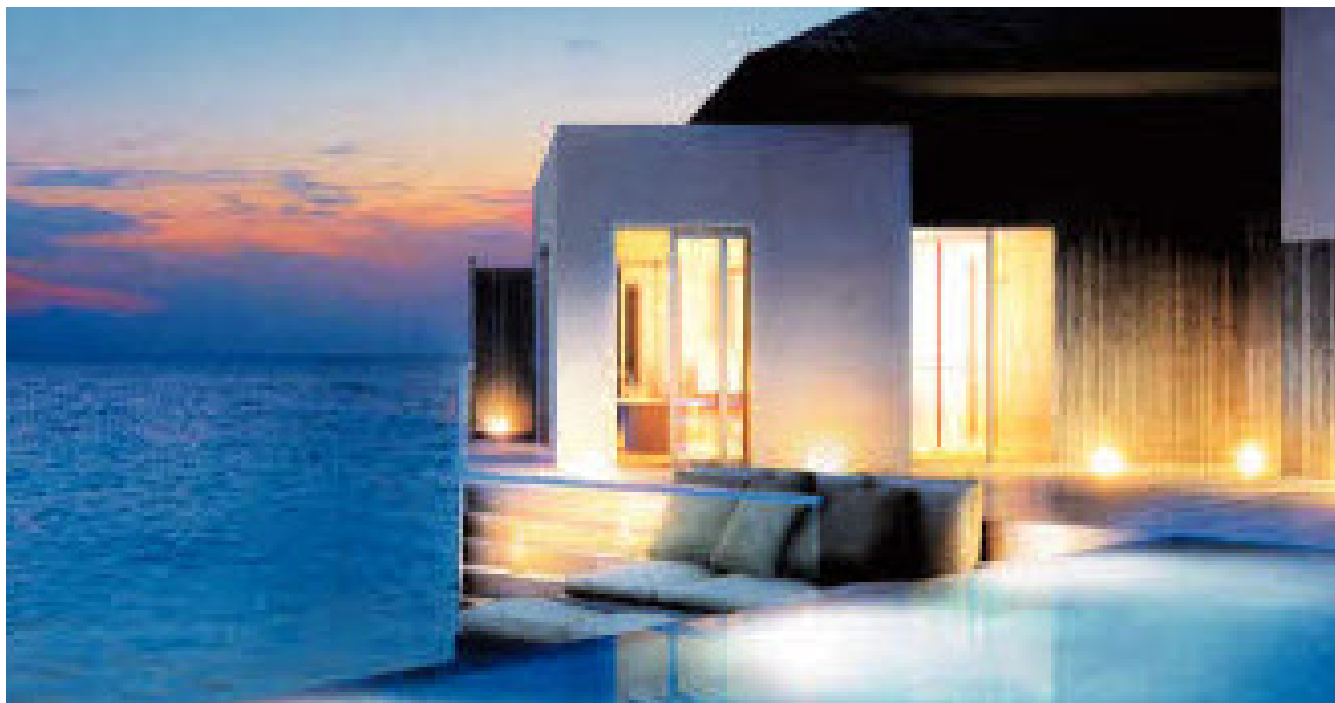
Carl Ettensperger baut direkt über dem Wasser, auf Dellis Cay entstehen die derzeit einzigen „over-the-water-Villas“ in der Karibik
