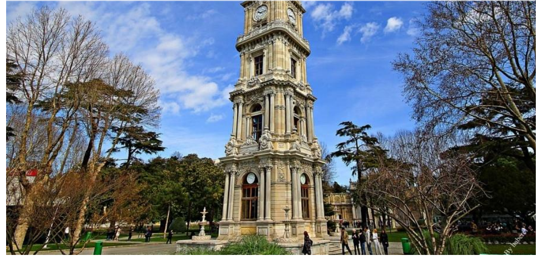
Dolmabahçe Saat Kulesi
